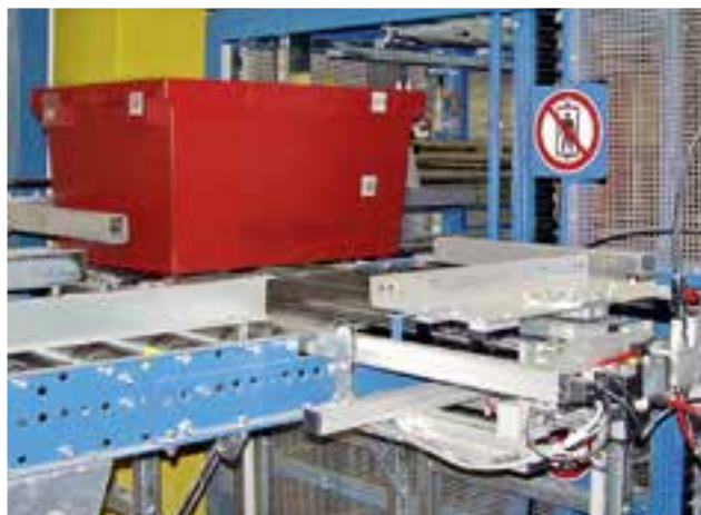
Станция подачи грузов тактового подъемника для пластиковых контейнеров
